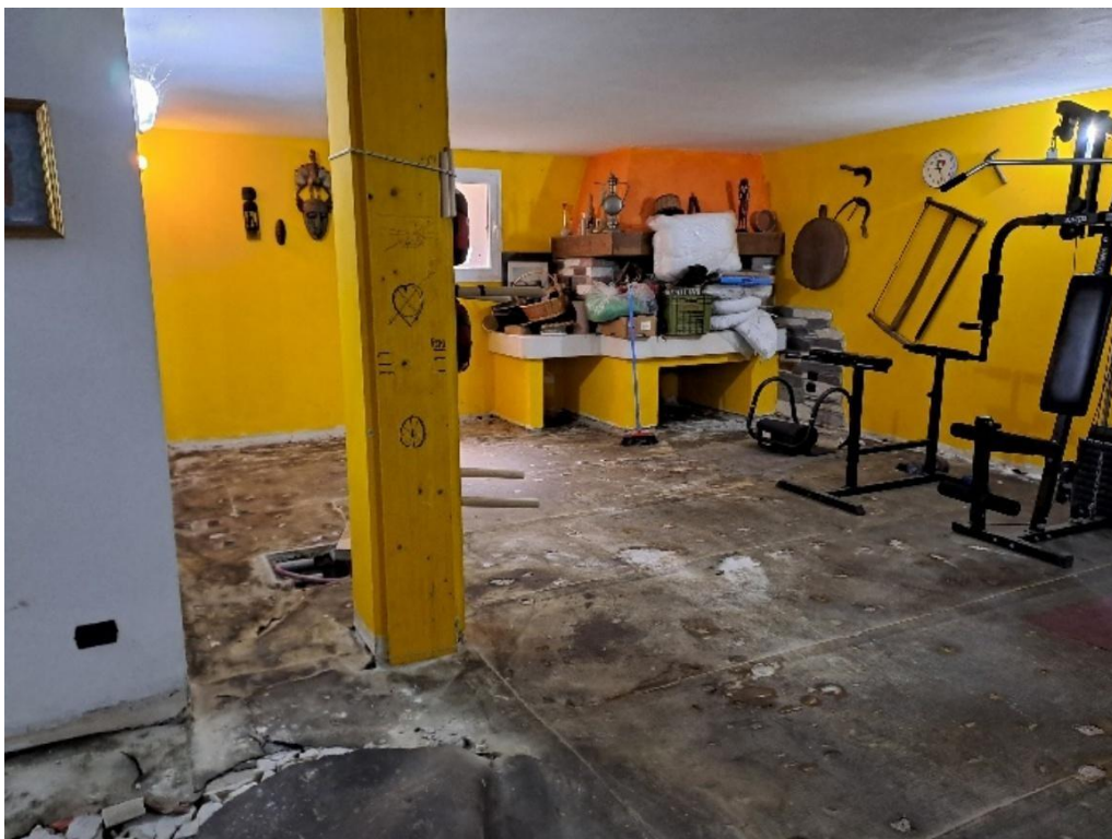
Vista del ripostiglio interrato
